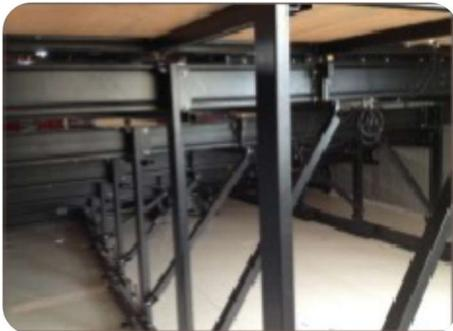
Estructura diseñada con soportes verticales e inclinados para la barra horizontal de cada fila permitiendo soportar mayor carga en la superficie de nuestras gradas.
